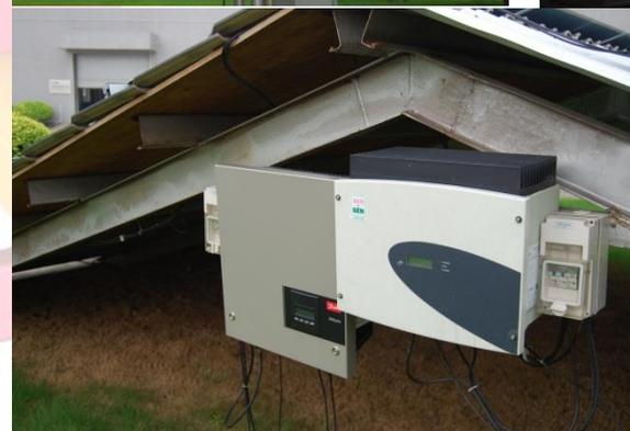
**THIN FILM AND PV SOLAR PANEL / CONTROLLER & INVERTER
